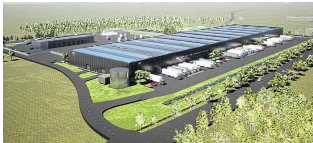
Das 20.600 Quadratmeter große Logistikzentrum bekommt sechs Rampen mit 24 Verladebühnen und separate Sektionalttore für die verschiedenen Mieter. 500 Quadratmeter sind für Büroflächen vorgesehen. Foto: Goldbeck GmbH
